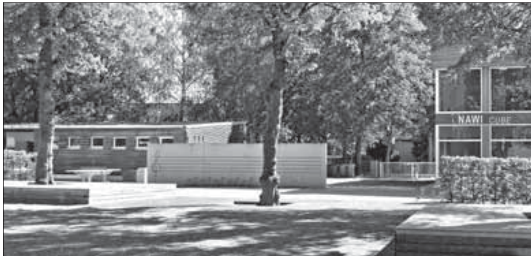
Blick auf Flachbau und sanierte Podeste
