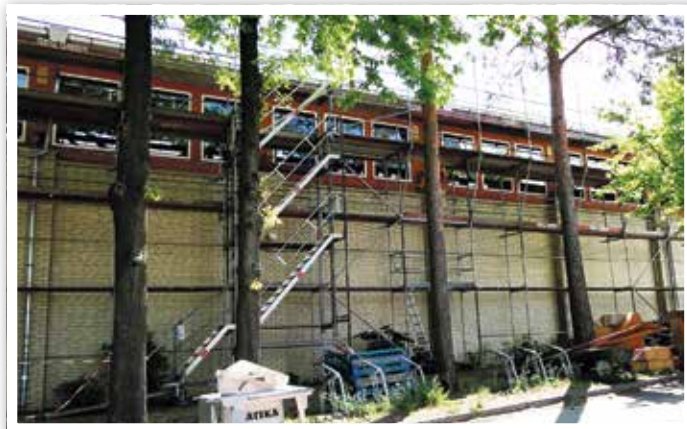
Die Sporthalle ist großflächig abgesperrt. Hier die Rüstung von der Parkplatzseite aus.
